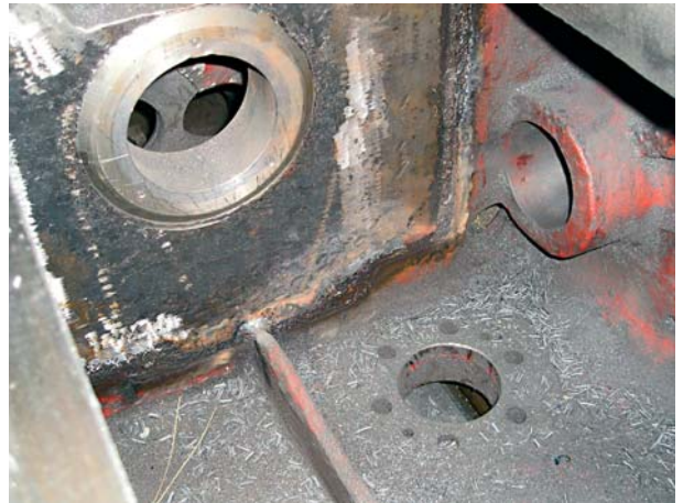
Вварная стальная перегородка
